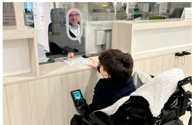
Im Haupteingang wurde der Bereich beim Portier sowie bei den Ambulanzen barrierefrei umgebaut. Ein Bereich wurde sowohl in der Portierloge als auch bei der Anmeldung zu den Ambulanzen baulich tiefer gelegt, um es Rollstuhlfahrer*innen zu ermöglichen, auf Augenhöhe mit Mitarbeiter*innen zu kommunizieren und Unterlagen einfacher übergeben zu können.
